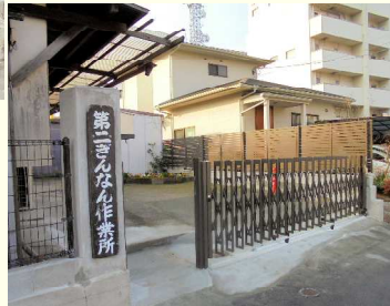
完成した門扉
